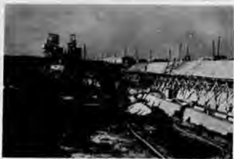
Bau eines Tiefbunkers
